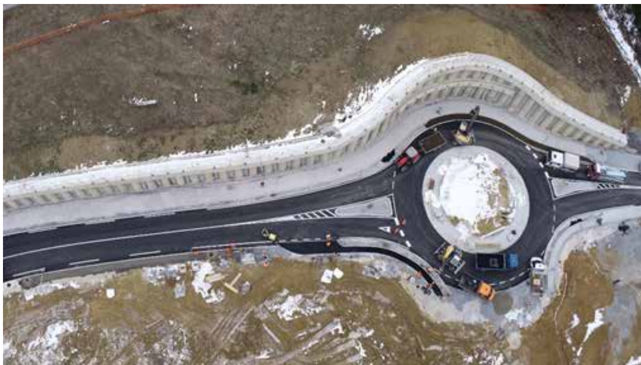
Zaključevanje cestnih del v območju oporne konstrukcija 10-OK-14 in krožišča K10 (vir: Geodetska služba PV)
