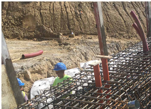
Izvedba armature vezne grede (slika levo) in polnilnega betona med piloti z brizganim betonom (slika desno)
