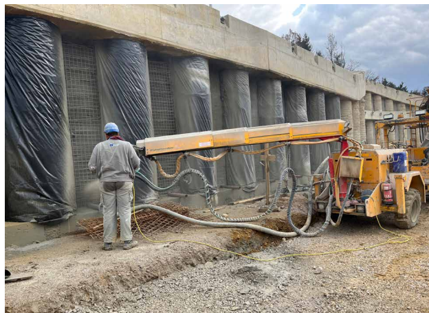
Izvedba armature vezne grede (slika levo) in polnilnega betona med piloti z brizganim betonom (slika desno)
