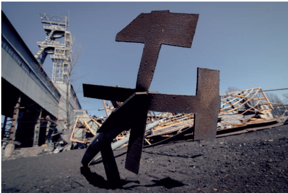
W maju 2015 r. z sosnowieckiej kopalni „Kazimierz-Juliusz” wyjechała ostatnia tona węgla. „Gruba” została za symboliczną złotówkę przekazana do Spółki Restrukturyzacji Kopalń i przez nią została zlikwidowana.
