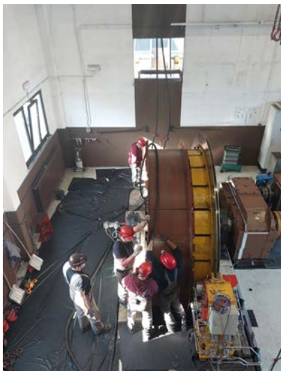
Priprava na izvlek stare vrvi iz jaška. Pri tem delu je ključnega pomena usklajeno sodelovanje ekipe in natančno spremljanje zaporedja postopka, da se zagotovi varno in učinkovito izvedbo naloge.
